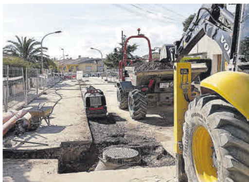
Obras de las redes municipales.
